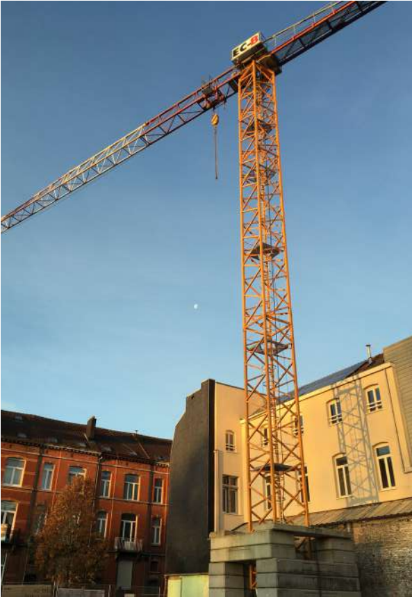
Chantier du projet Transvaal, décembre 2022
